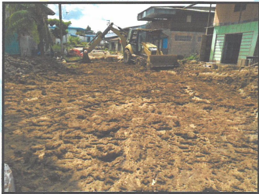
CONFORMACIÓN A NIVEL DE SUB RASANTE, CON MAQUINARIA, PROG. 0+200
