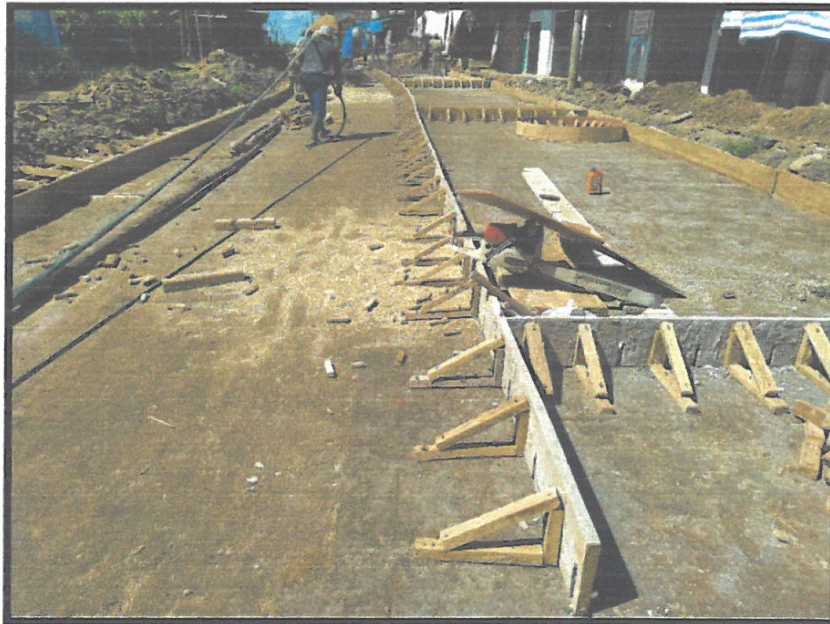
ENCOFRADO EN PROG. 0+100 A 0+160
