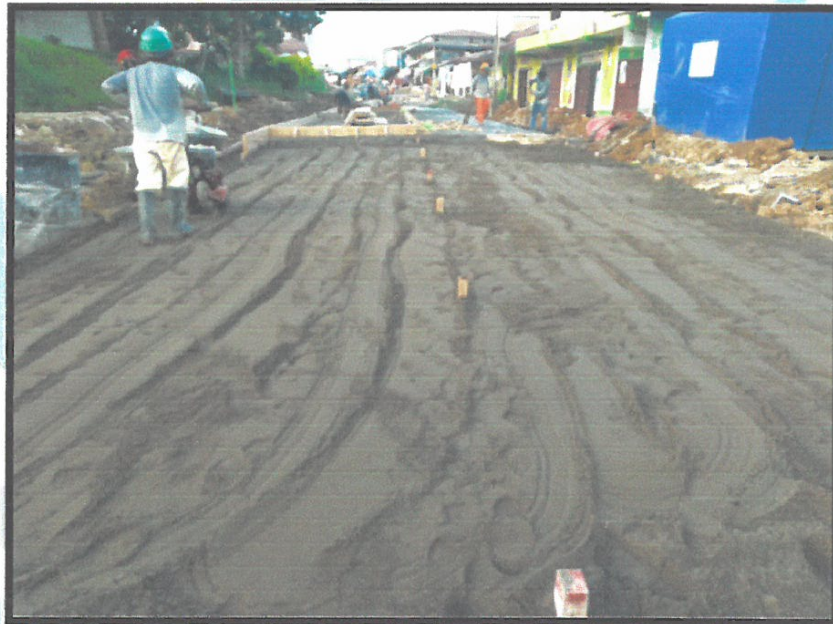
RELLENO CON MATERIAL DE PRESTAMO, COMPACTADO, PROG. 0+100 A 0+180
