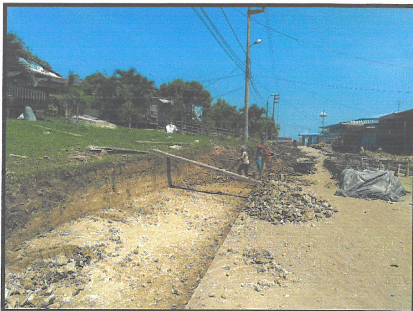
EXCAVACIÓN DE ZANJA EN MURO DE CONTENCIÓN
