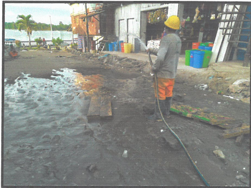
CURADO DE LOSA DE PAVIMENTO, PROG. 0+000 A 0+060
