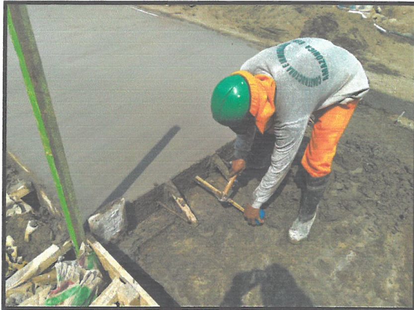
MORTERO F'C=210KG/CM2, ACERO LISO DE 5/8", PROG. 0+200
