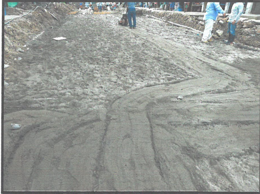
RELLENO CON MATERIAL DE PRESTAMO, COMPACTADO, PROG. 0+000 A 0+060
