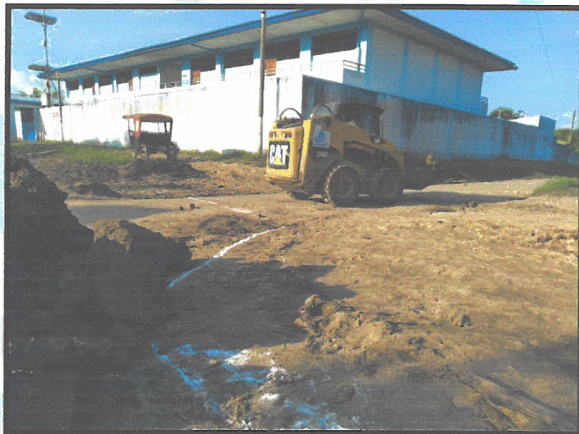
ELIMINACIÓN DE MATERIAL EXCEDENTE
