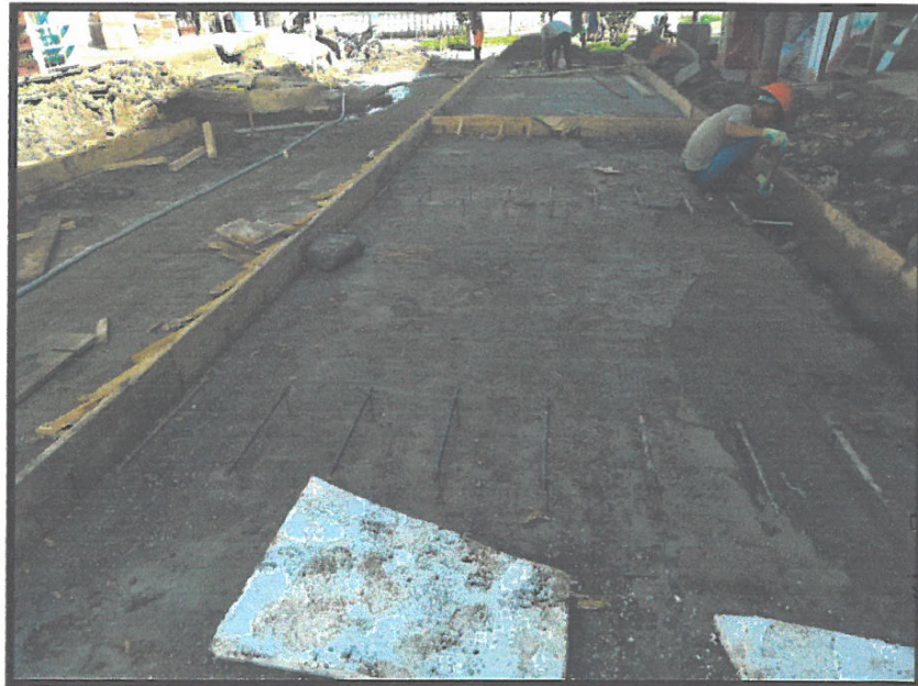
PASADORES DE ACERO LISO DE 5/8", ENCOFRADO EN PAÑOS DE 9*3M DE LOSA DE PAVIMENTO, PROG. 0+000 A 0+060
