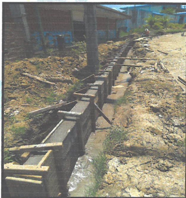
MORTERO F'C=210KG/CM2 EN MURO DE CONTENCIÓN, PROG. 0+220 A 0+260
