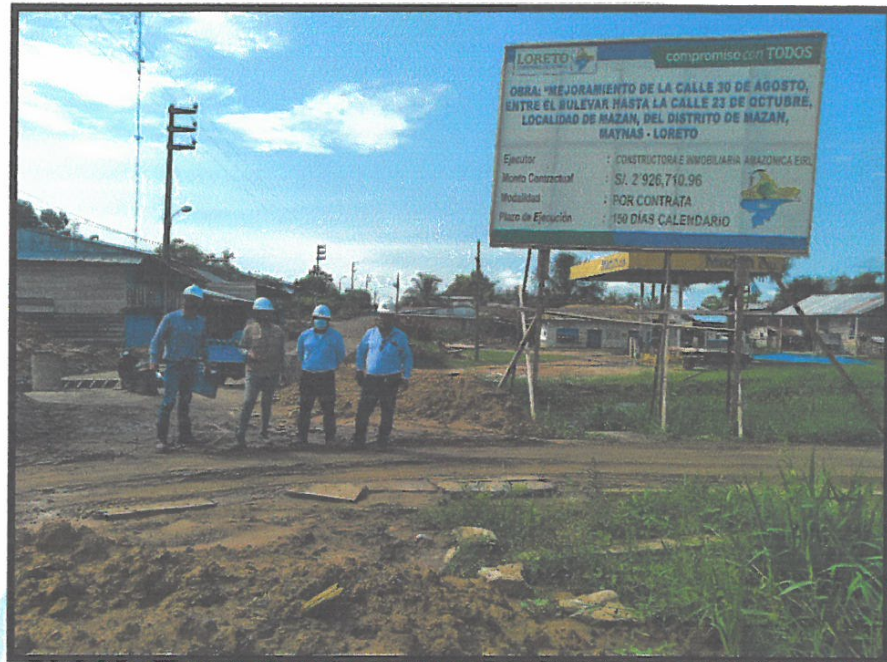
VISTA DEL CARTEL DE OBRA
