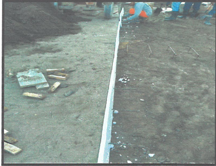
ASERRADA JUNTA DE CONTRACCIÓN Y ARTICULACIÓN, PROG. 0+000 A 0+060
