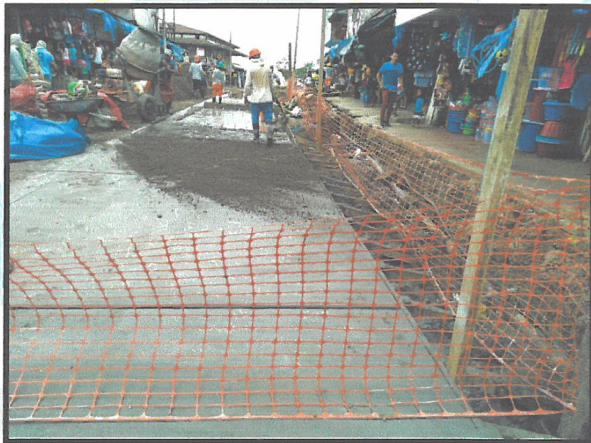
MORTERO F´C=210KG/CM2 DERECHO, PROG. 0+000 A 0+060 EN LOSA DE PAVIMENTO
