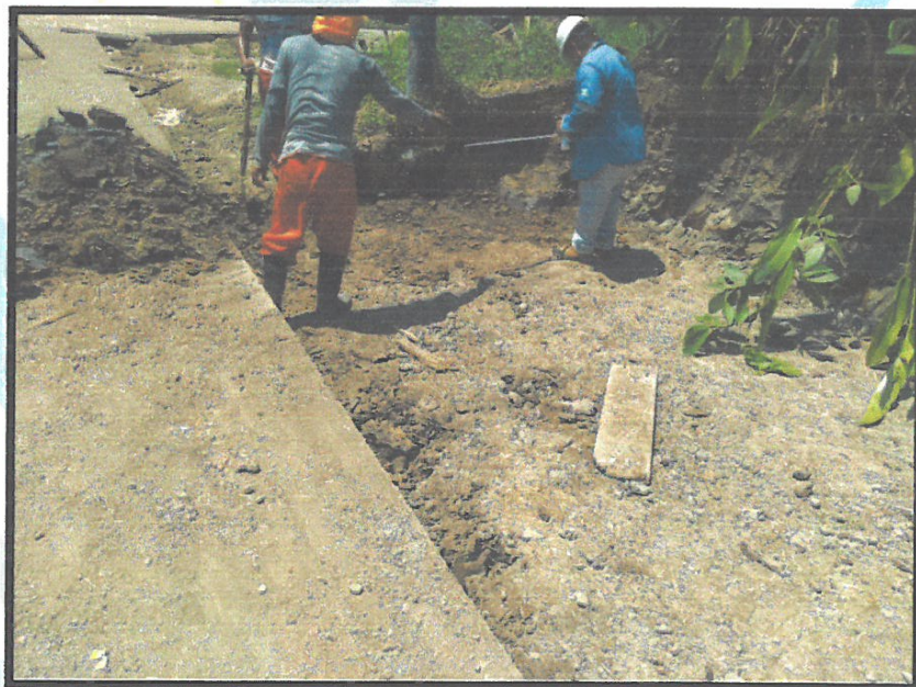
NIVEL Y TRAZO EN MURO DE CONTENCIÓN
