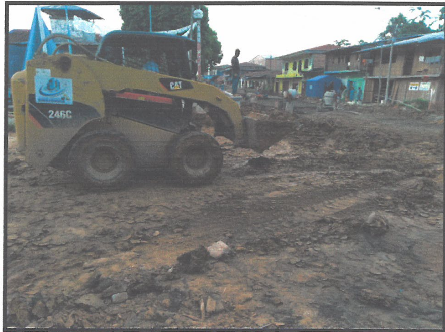
ELIMINACIÓN DE MATERIAL EXCEDENTE
